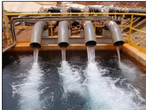
Figure 14 : Arrivée des 4 drains sous la géomembrane au puits de pompage aval
