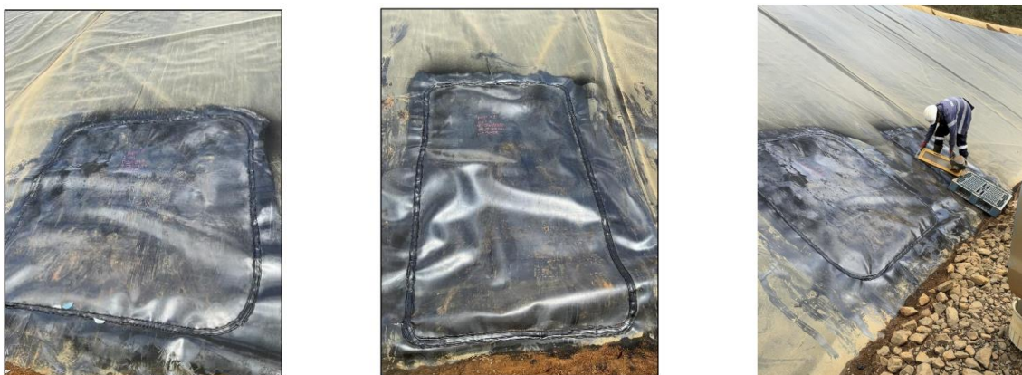
Figure 36 : Réparation de la géomembrane
