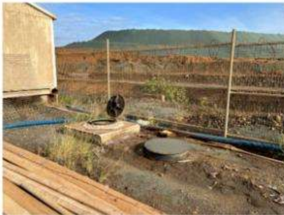
Débourbeur-séparateur à hydrocarbures – EMC Doniambo
