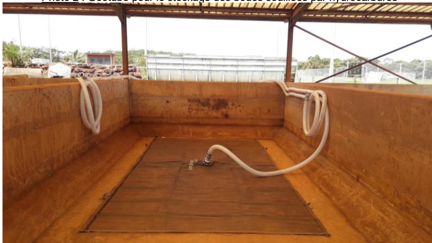
Photo 2 : Géotube pour le stockage des boues souillées par hydrocarbures
