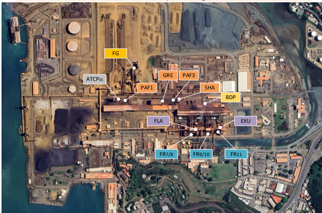
Figure 117 : Implantation des cheminées entrant dans le cadre de l'autosurveillance continue comme définie par l'arrêté n°11387-2009-ARR-DIMENC du 12 novembre 2009 relatif à l'exploitation de l'usine de Doniambo.
