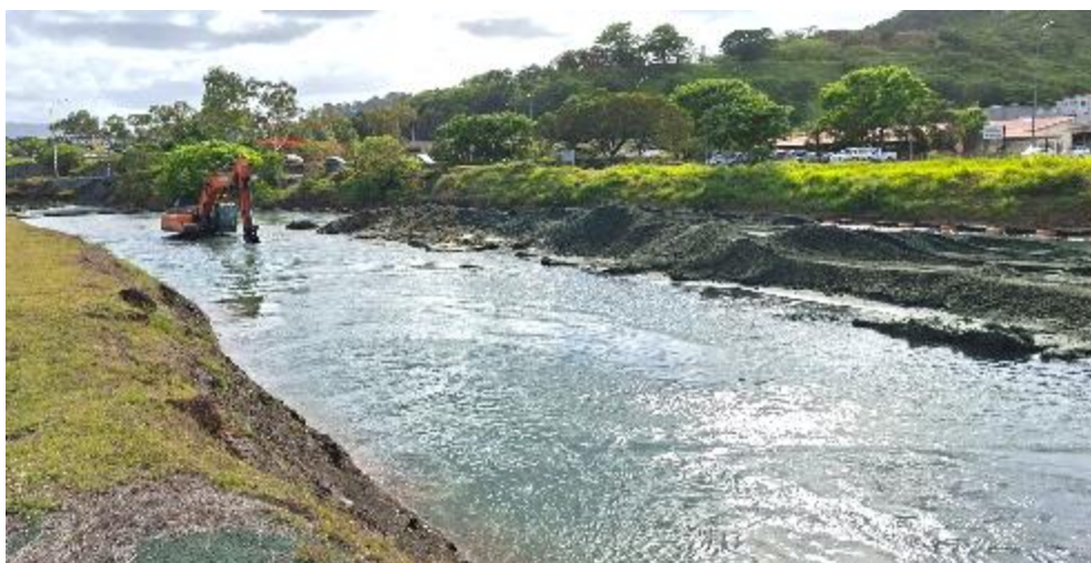
Figure 13 : opération de curage du lot B dans le canal E1
