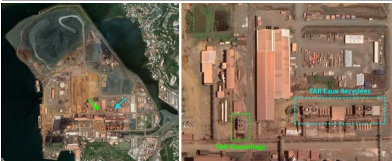
Figure 2 : Localisation des tours de refroidissement d'eau recyclée
