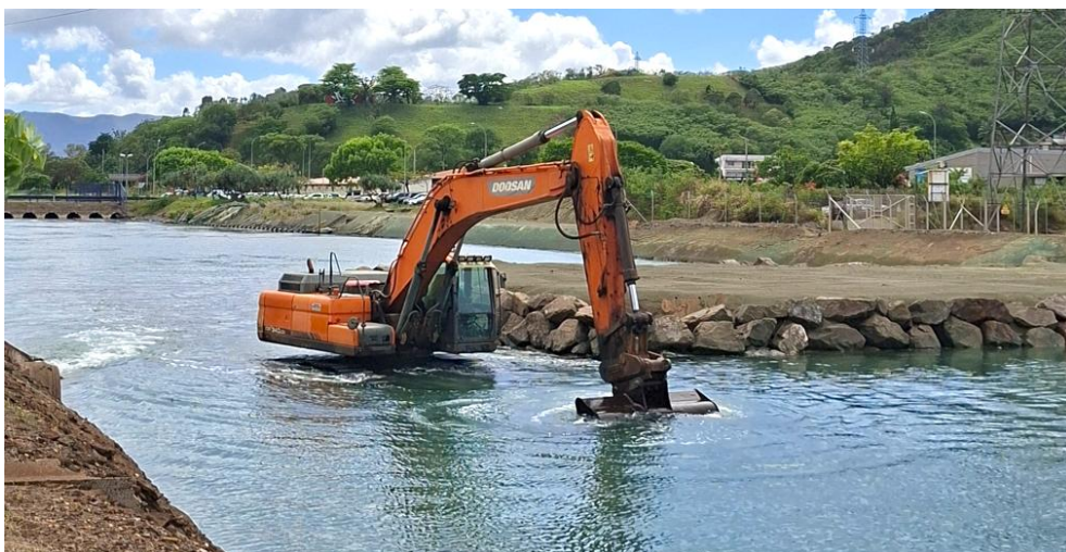
Figure 12 : opération de curage du lot A dans le canal E1
