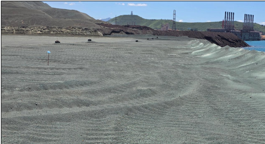
Figure N°3 : Plateforme au niveau de la zone maritime
