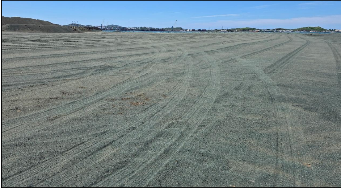
Figure N°2 : Plateforme au niveau de la zone maritime
