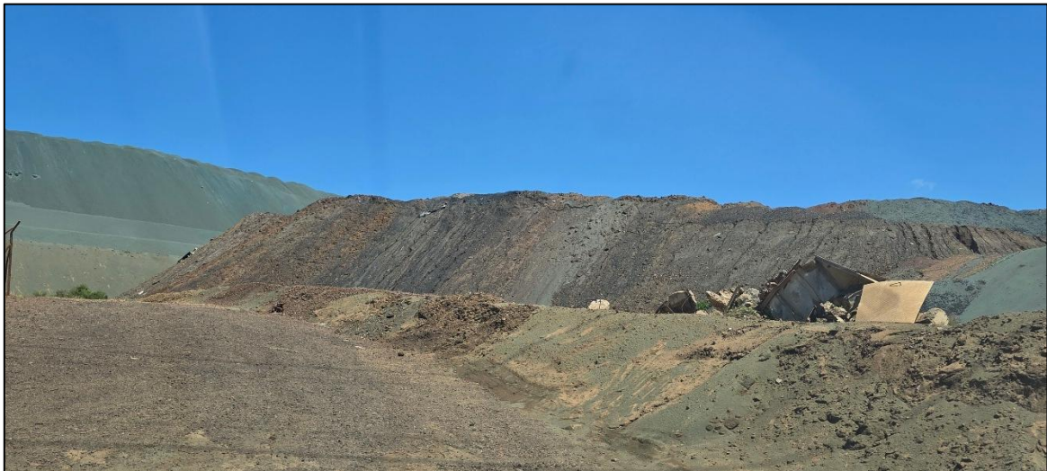
Figure N°5 : Remblai existant composé d'un mélange de de charbon, minéral et scorie de fusion
