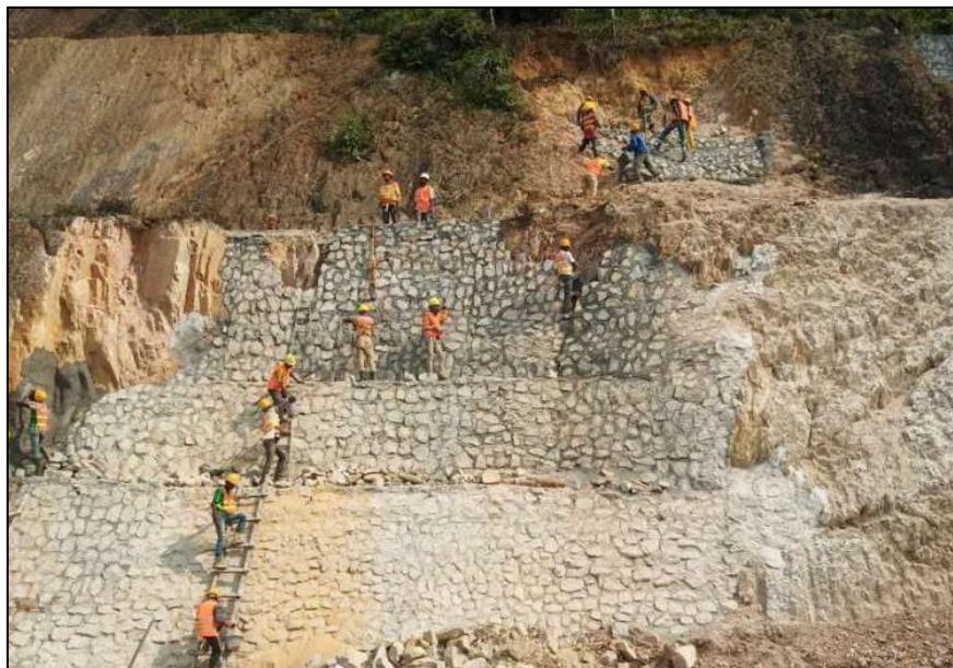
Figure N°49 : Descente d'eau en Perrés maçonnés
