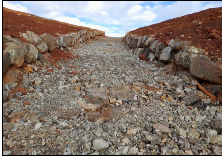
Figure 16. Descente d'eau en enrochements
