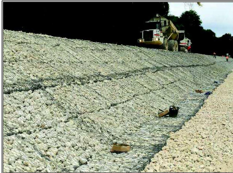
Figure N°48 : Descente d'eau en Matelas Reno
