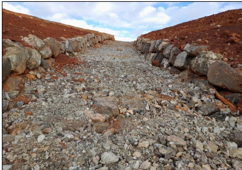
Figure N°46. Descente d'eau en enrochements
