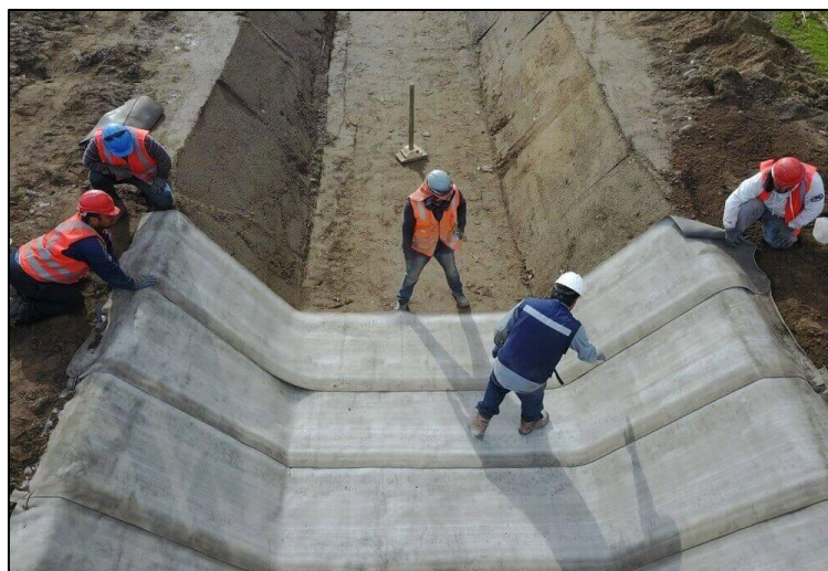
Figure N°50 : Descente d'eau en concrete canvas
