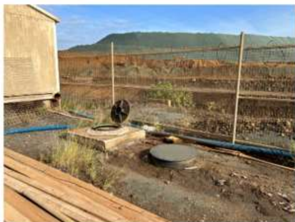
Débourbeur-séparateur à hydrocarbures – EMC Doniambo
