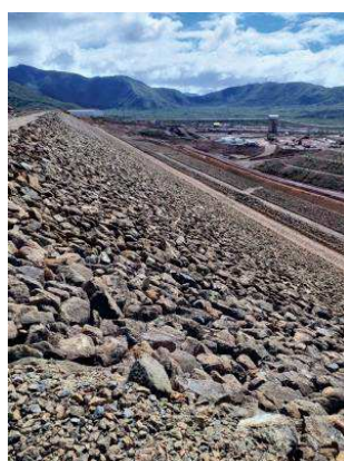
Figure 7 : talus amont du barrage
