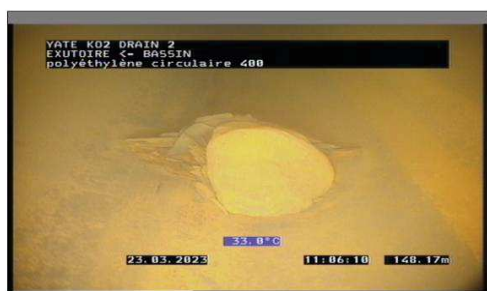
Figure 12 : Dépôt de matériaux grossiers - GEO2 (campagne 2023)
