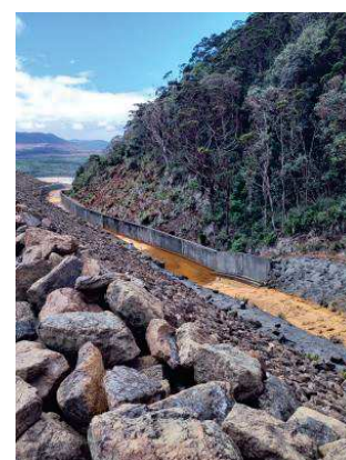
Figure 9 : drain Sud et bajoyer
