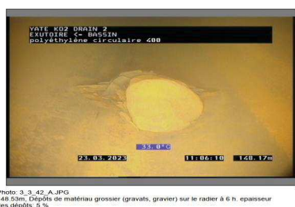
Figure 7 : Dépôt de matériaux grossiers - GEO2 (campagne 2023)
