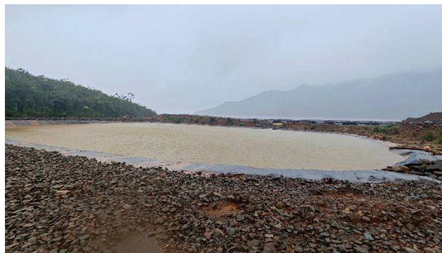
Figure 6 : Ouvrage de mise hors d'eau Nord
