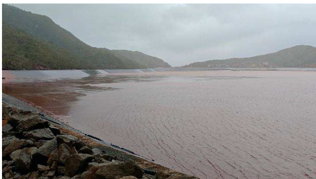
Figure 7 : Bassin KO2 - vue du chainage 300
