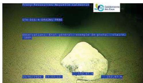
Figure 12 : Dépôt de matériaux grossiers - GEO2 (campagne 2025)
