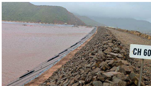
Figure 8 : Crête de la digue - vue chainage 600
