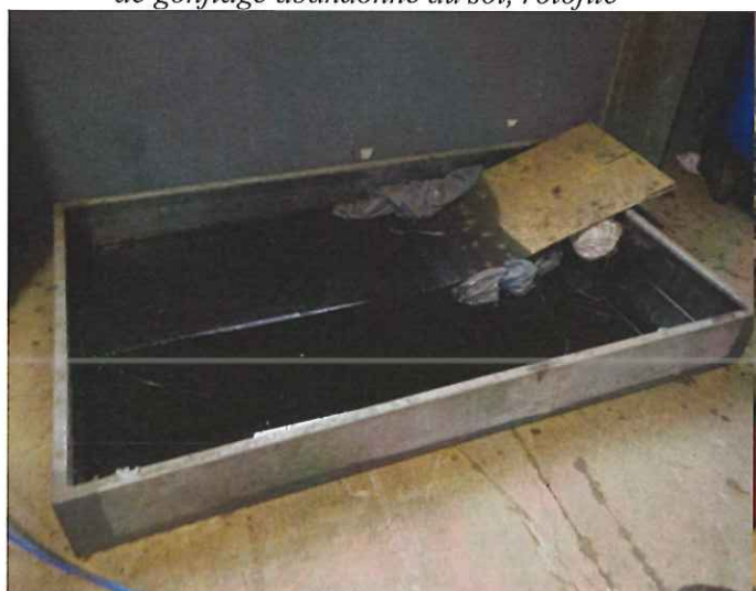
Photo 17 : Bac de rétention d'huile contenant des huiles non identifiées, une planche en bois et du plastique
