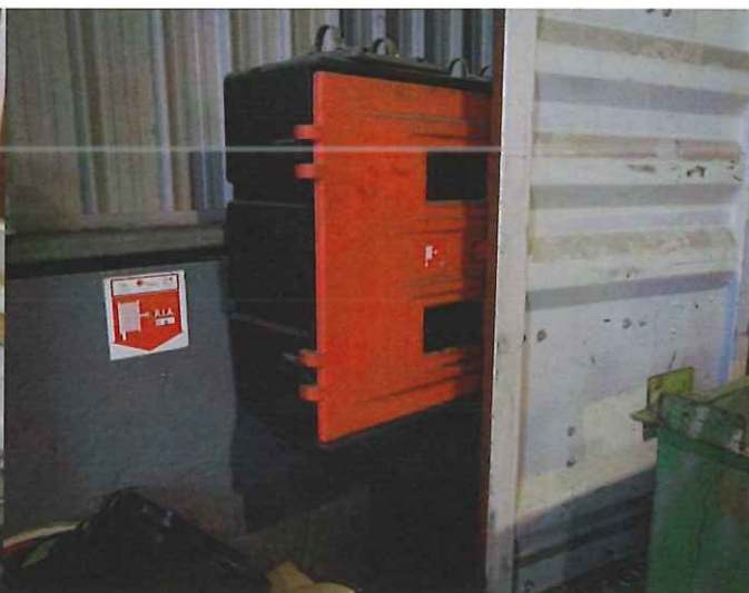
Photo 14 : RIA bloqué par la porte du container, elle-même bloquée par une benne de stockage
