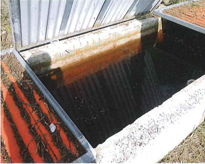
Photo 7 : Trop plein de la cuve de stockage des lixiviats
