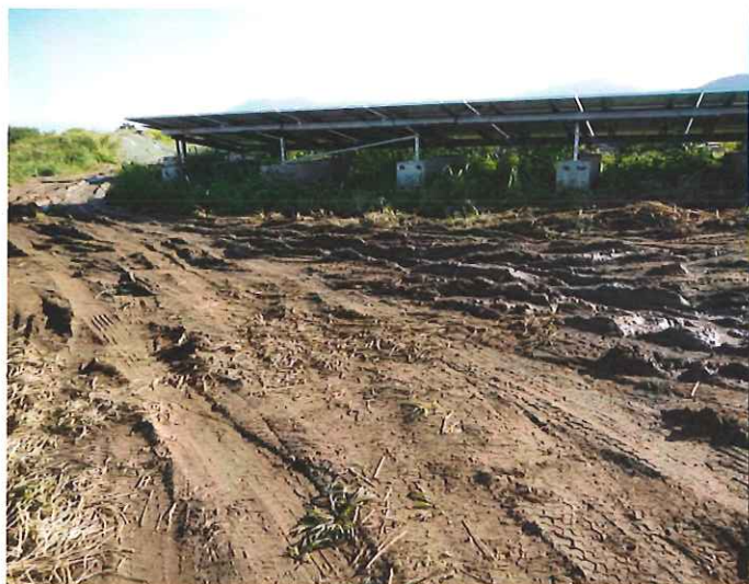
Photo 3 : Chemin d'accès à recouvrir de schistes
