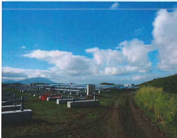
Photo 1 : Ferme photovoltaïque avec panneaux prêts à l'emploi en arrière-plan et longrine prêtes à recevoir les panneaux au premier plan.
