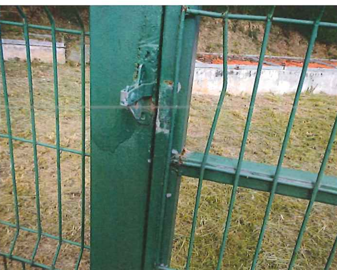
Photo 6 : Accès à la cuve de stockage devant être sécurisé par un cadenas
