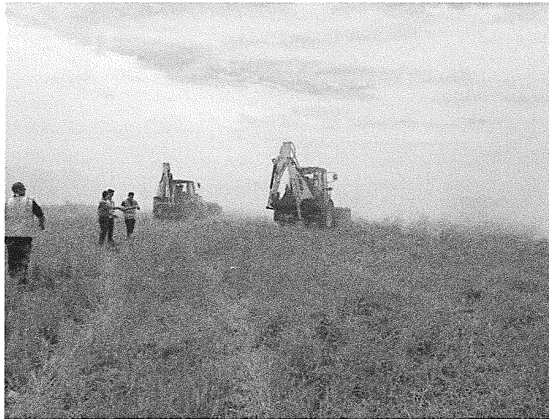
Photo 2 : étouffement par épandage de scorie, avancée en parallèle face au flamme
