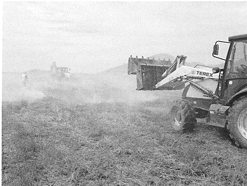
Photo 3 : Travail en face à face, décapage de la surface de la plateforme et amené vers le centre des herbages pour arrosage.
