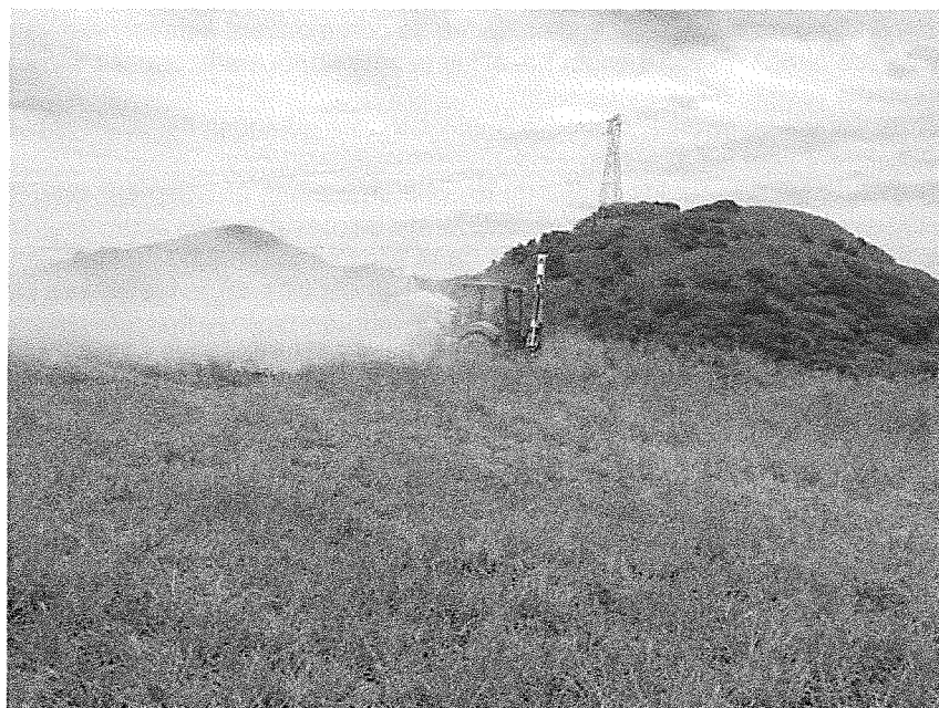
Photo 1 : premier engin arrivé sur la zone, épandage d'un godet de scorie
