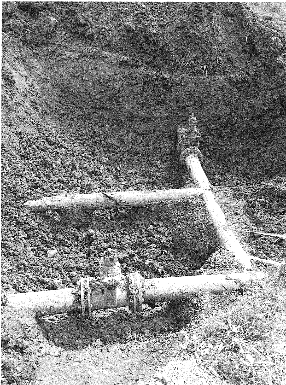
Mise à nu des vannes – réseau percé à réparer
