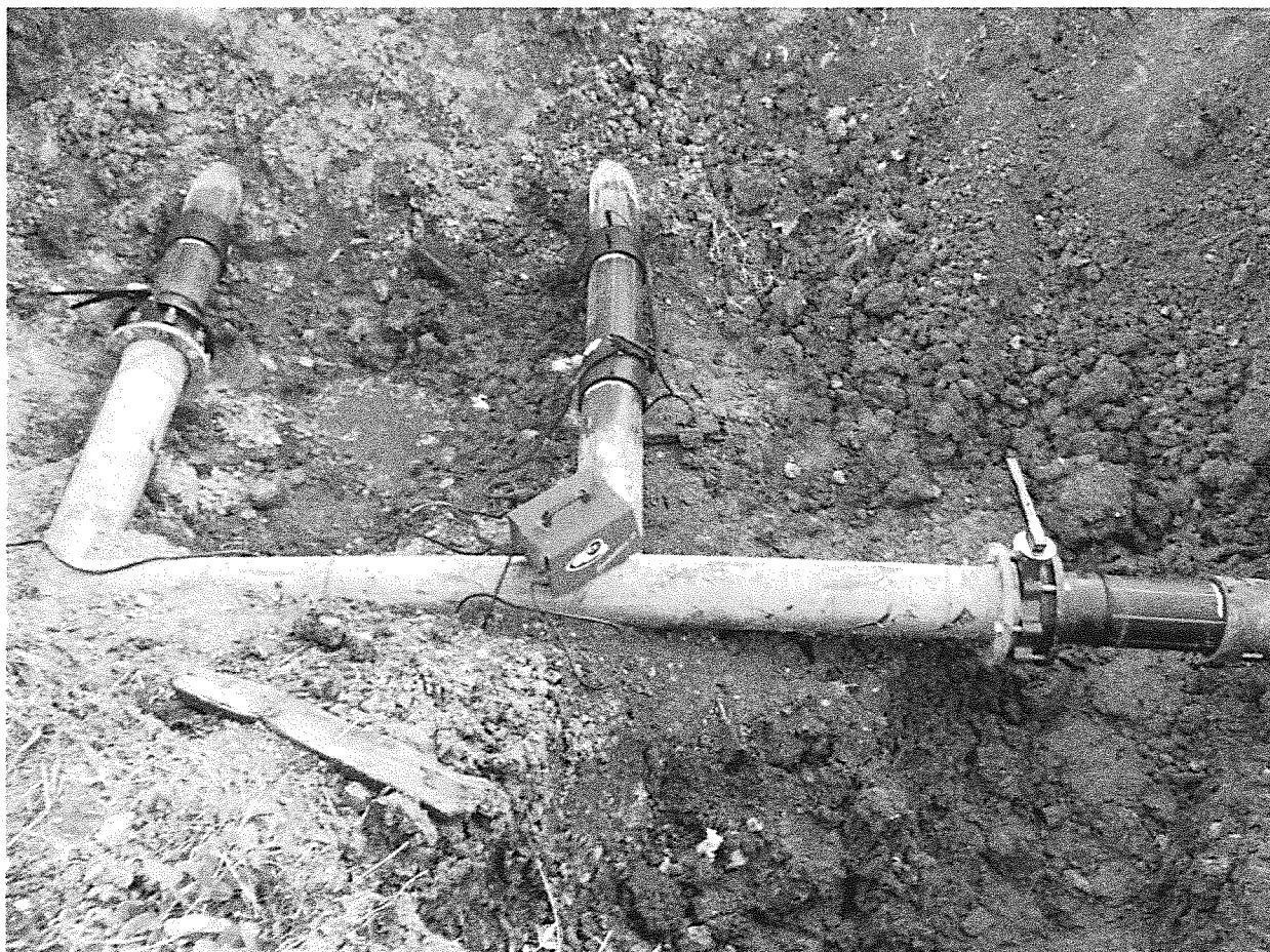
Pose des vannes, collets et tubes et soudure des manchons électrosoudables
