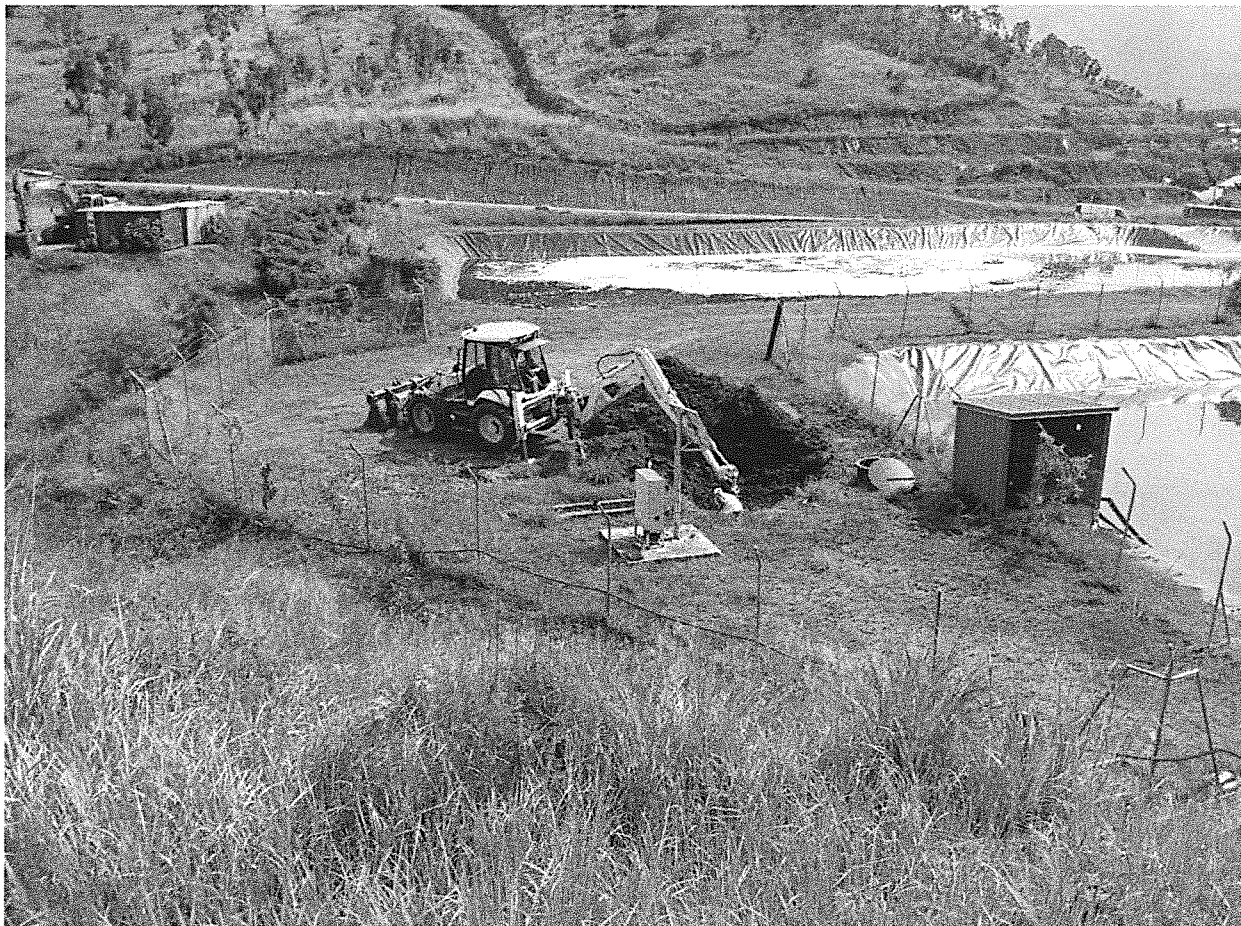
Fouille des vannes existantes
