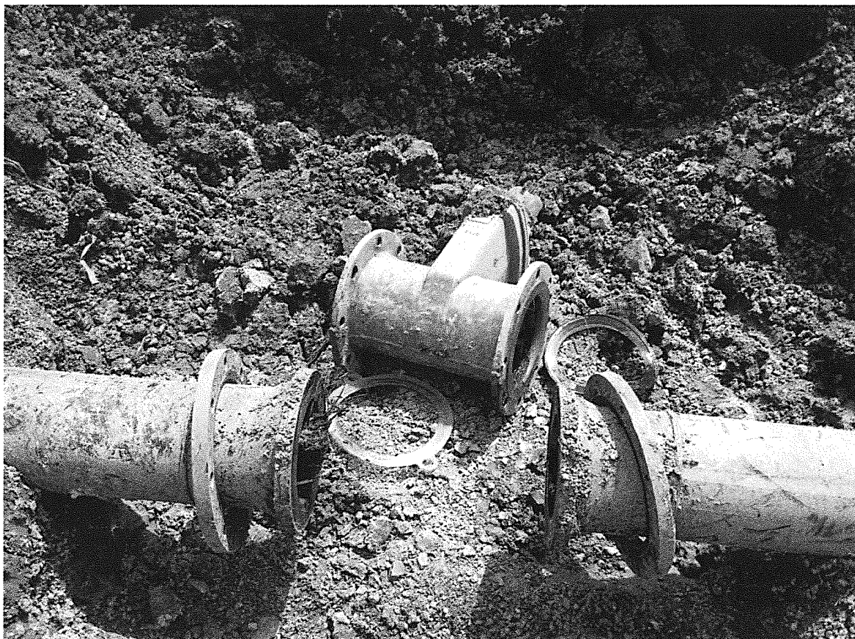
Démontage des vannes existantes
