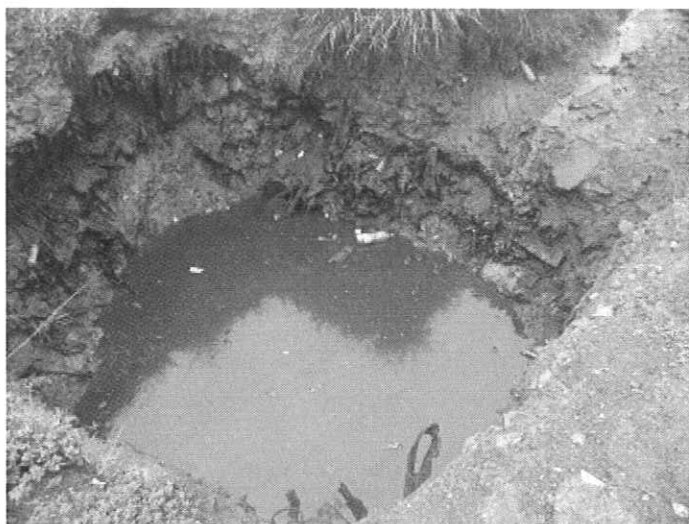
Photo 7 : Trou réalisé pour récupérer les eaux polluées provenant du traitement par géosacs
