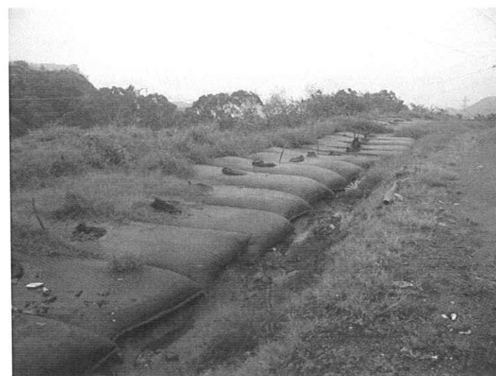
Photos 5 et 6 : Traitements des boues par géosacs
