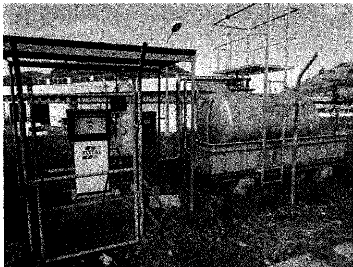
Photos 1 et 2 : Unité de distribution de carburant
