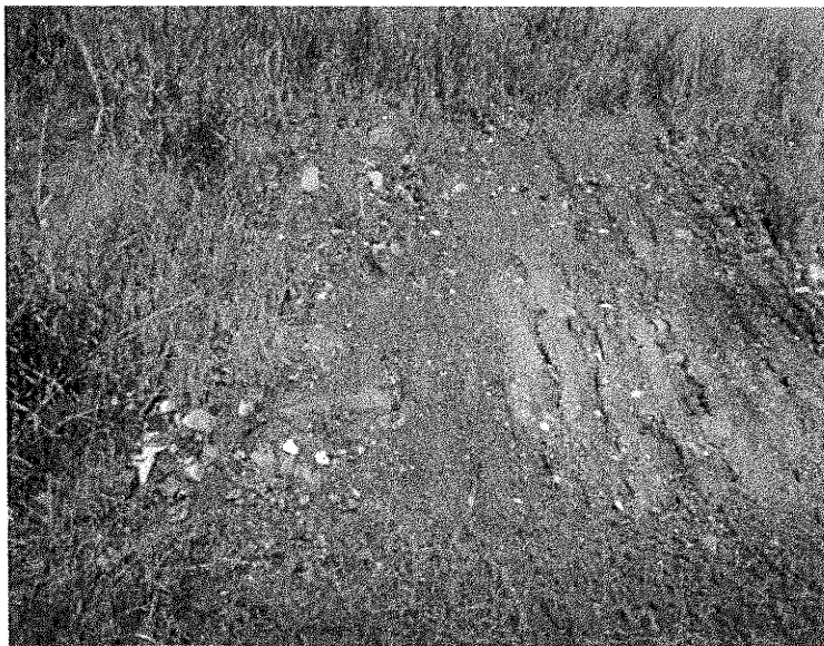
Photo 18 : Présence de petites ravines en cours de végétalisation
