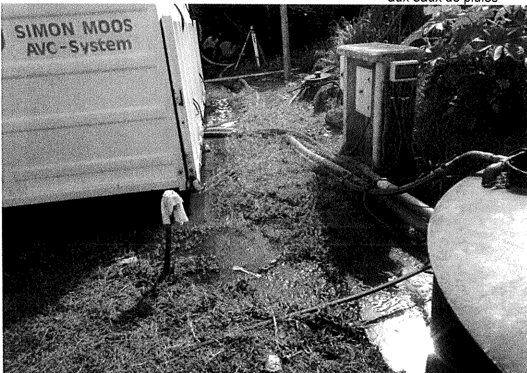
Photo 13 : Fuite dans le milieu naturel d'eaux chargées provenant du traitement des boues
