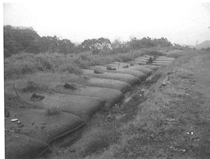
Photos 5 et 6 : Traitements des boues par géosacs
