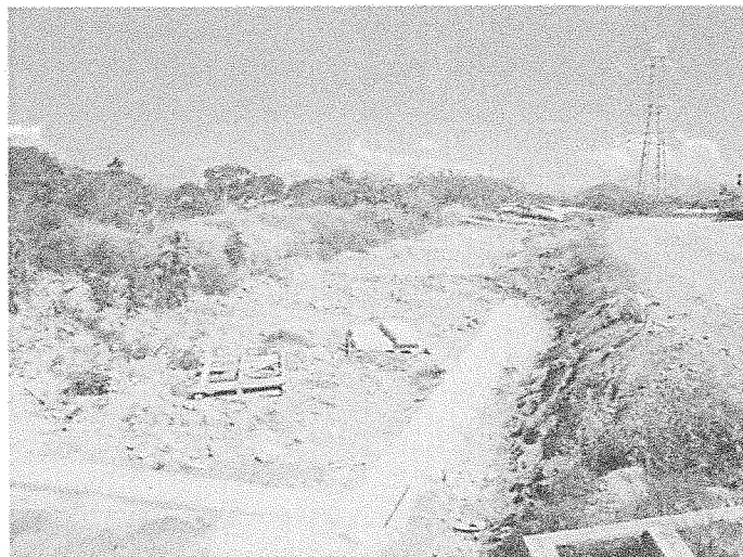
Photos 2 : caniveaux, en cours d'installation, permettant la récupération des eaux de la plateforme de séchage des boues
