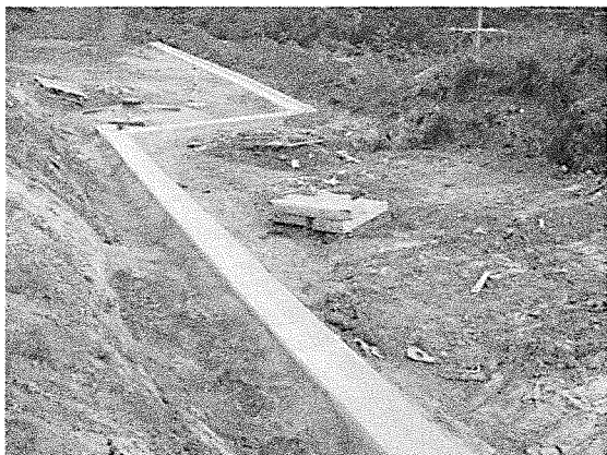
Photos 1 et 2 : mise en place du caniveau et de la cuve, enfouissement du réseau des eaux collectées vers la station de traitement bio-disques
