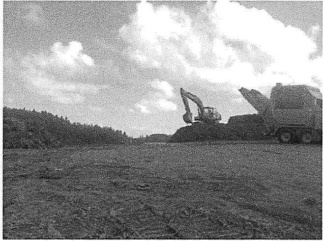
Photo 3 : Vue d'ensemble de la plateforme
