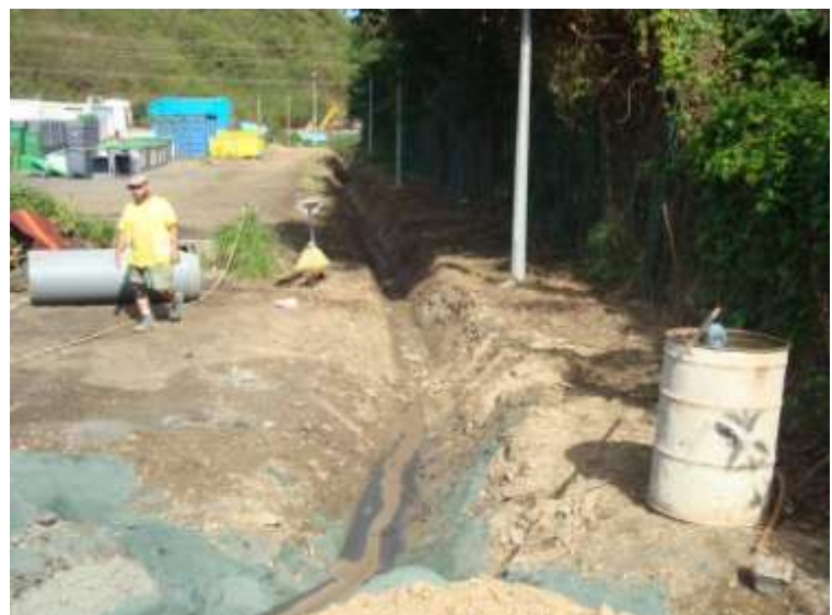
Photo 12 : travaux de gestion des eaux vers la rue Pelatan
