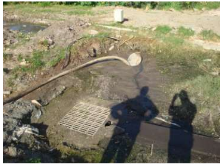
Photo 6 : zone de récupération des effluents provenant du quai des balayeuses et de la zone de séchage des boues (31 juillet 2012)
