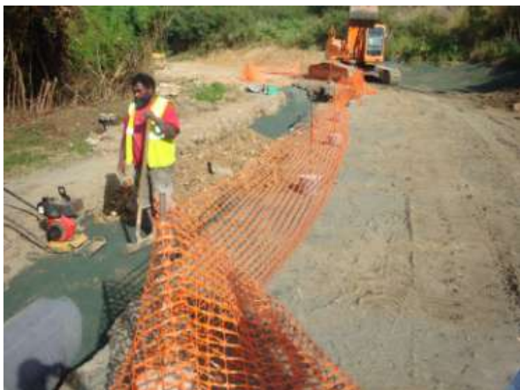
Photo 11 : travaux de gestion des eaux le long de la piste menant à la zone de séchage des boues
