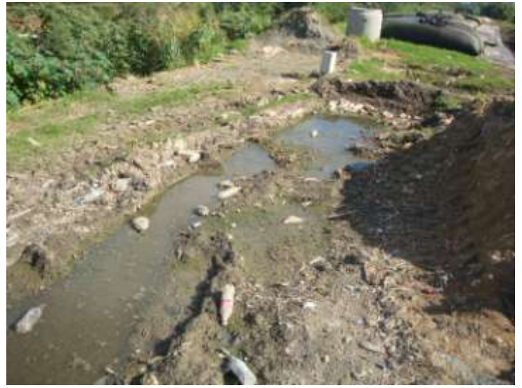
Photo 2 : mauvaise gestion des eaux du quai des balayeuses
