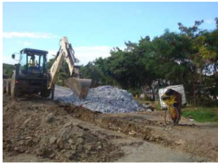
Photo 10 : travaux de gestion des eaux près du stock de chaux éteinte
