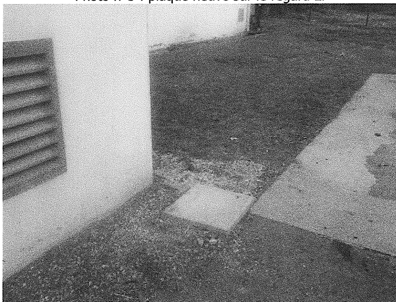
Photo n°3 : plaque neuve sur le regard EP
