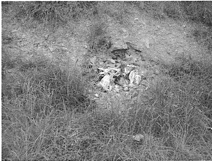
Photo 5 : Eboulement flanc de talus sur le chemin vers la zone de stockage des lixiviats
