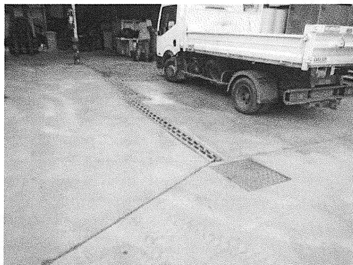
Figure 4 – Regard de collecte dirigeant les effluents vers le séparateur d'hydrocarbure
