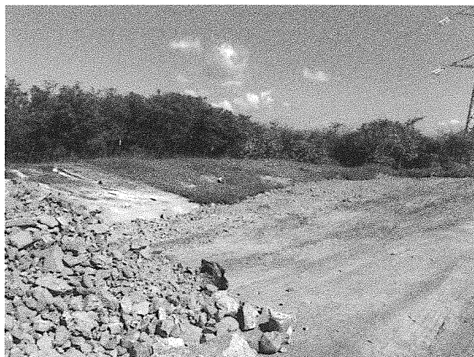
Photos 4 : travaux de reprise du fossé et de comblement de la fosse
