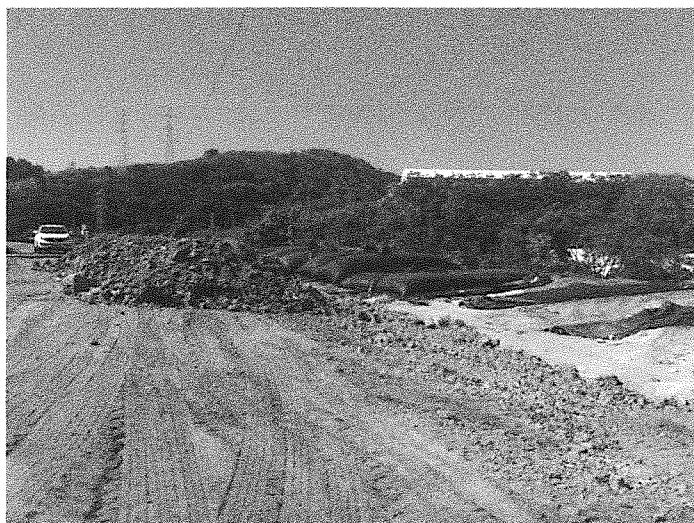
Photos 3 : mise en place de géomembranes supplémentaires sur l'avant et les côtés des géosacs
