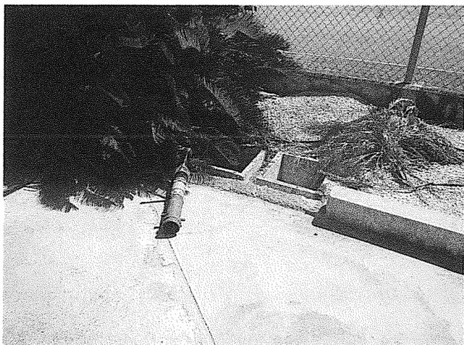
*Photo 1 : Emplacement du futur RIA avec raccord en place*
