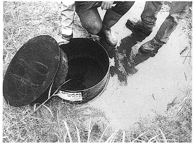
Photo 8 : Cuve de récupération de lixiviats ouverte présentant une quantité d'eau de pluies importante
