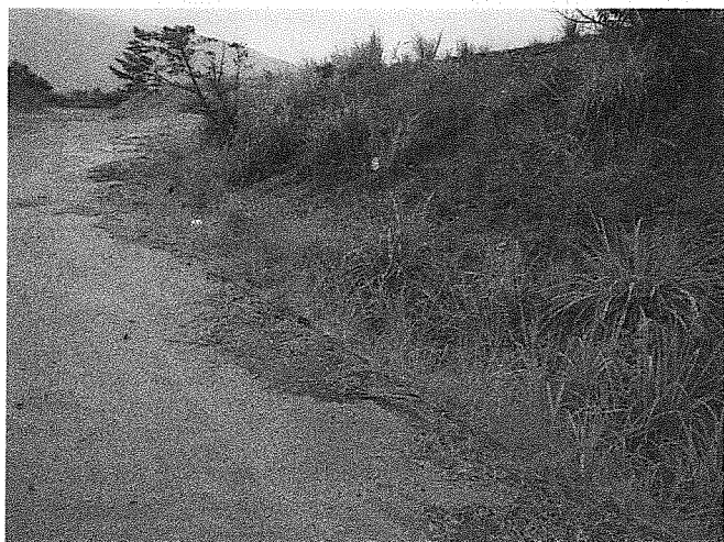
Photo 3 : Flan de massif et caniveau nécessitant un débroussaillage
