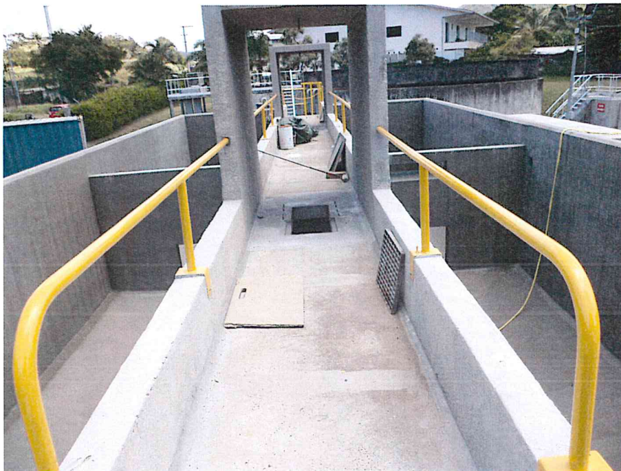
Travaux en cours sur le bassin d'aération
