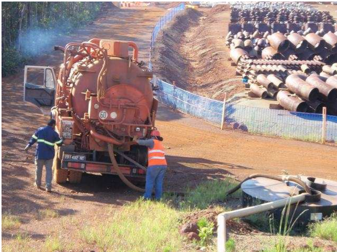
Photo 9 : Récupération par camion- vidange des « débordements » de la step au niveau d'une citerne de collecte située en contrebas des installations, en limite de la zone d'entreposage des matériaux
