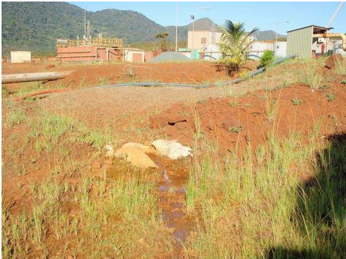
Photo 13 : Point de rejet d'effluents aqueux, à proximité du bassin de lagunage
