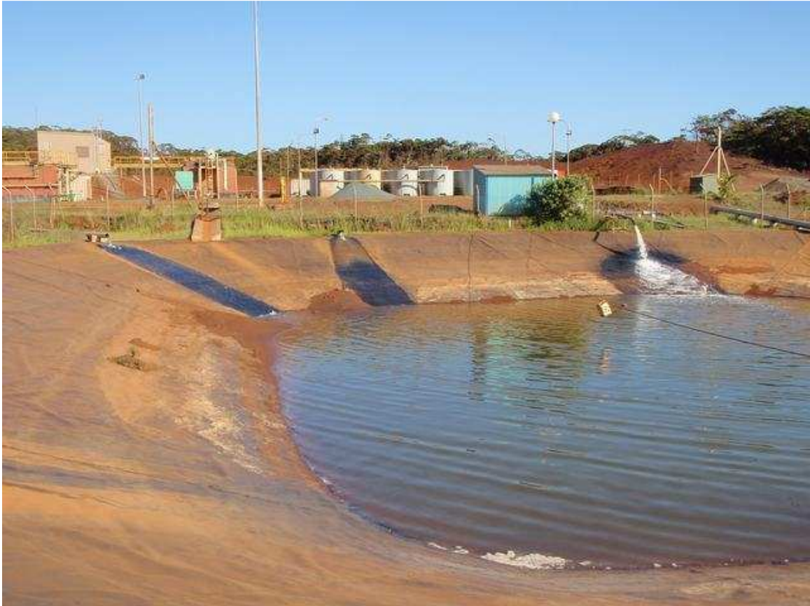
Photo 12 : Bassin de lagunage
