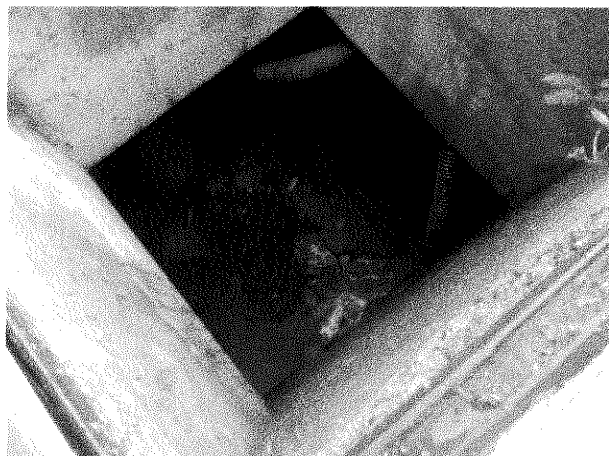
Entrée du décanteur primaire, avec le retour en tête des boues
