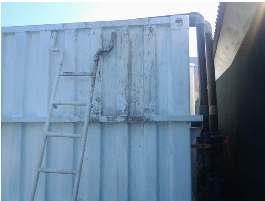
Figure 1 : Débordement d'eaux brutes au niveau d'un bassin d'aération
