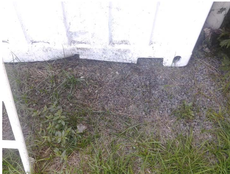
Figure 2 : Déversement d'eaux brutes au niveau du sol d'un bassin d'aération
