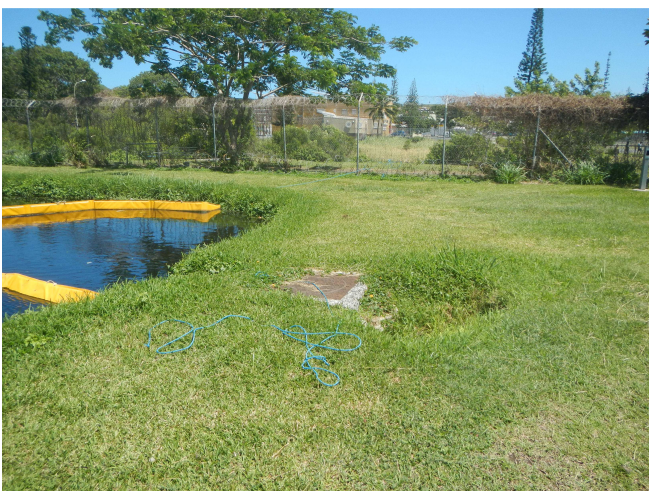
Figure 5 : Trou près du regard d'entrée des eaux traitées dans la lagune du site
