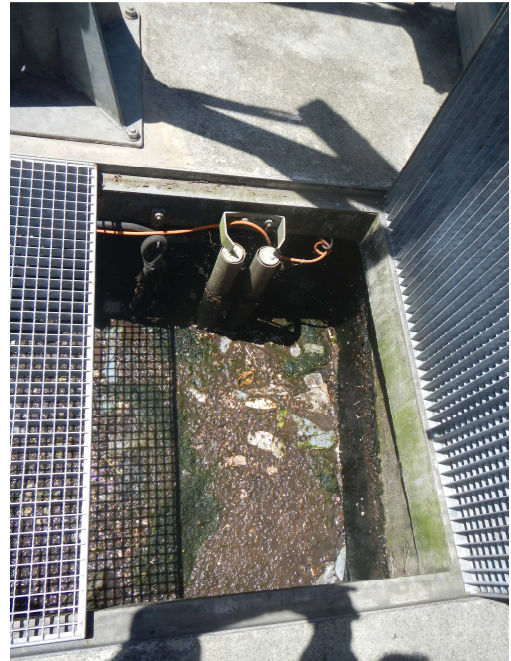
Figure 2 : Déchets présents dans le poste de recirculation des boues du clarificateur en entrée du site
