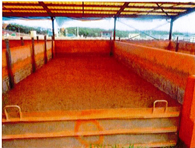
Figure 3 : Etat des lits de séchage (anciennement recouverts de roseaux)
