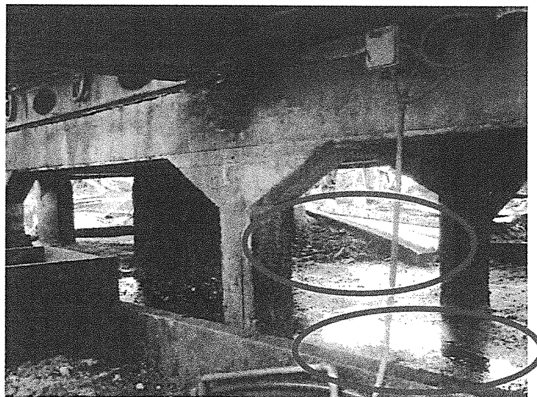
Image 3 – Rétention associée à la presse hydraulique : présence de résidus d'hydrocarbures, de terre et autres déchets
