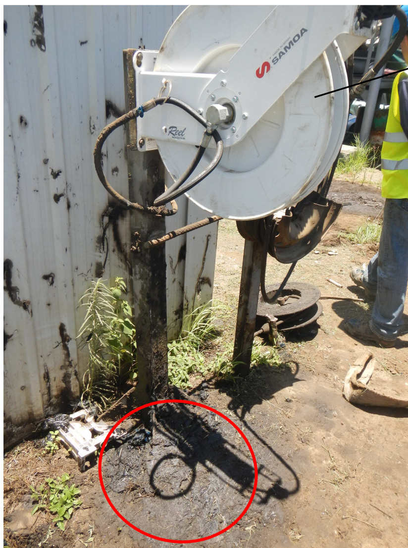
Photo 11 : dépôt de graisse au sol au niveau du distributeur de l'atelier de stockage des huiles neuves
