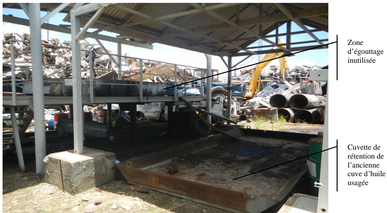
Photo 7 : suppression de l'activité d'égouttage de transformateurs et démantèlement de la cuve de stockage des huiles usagées
