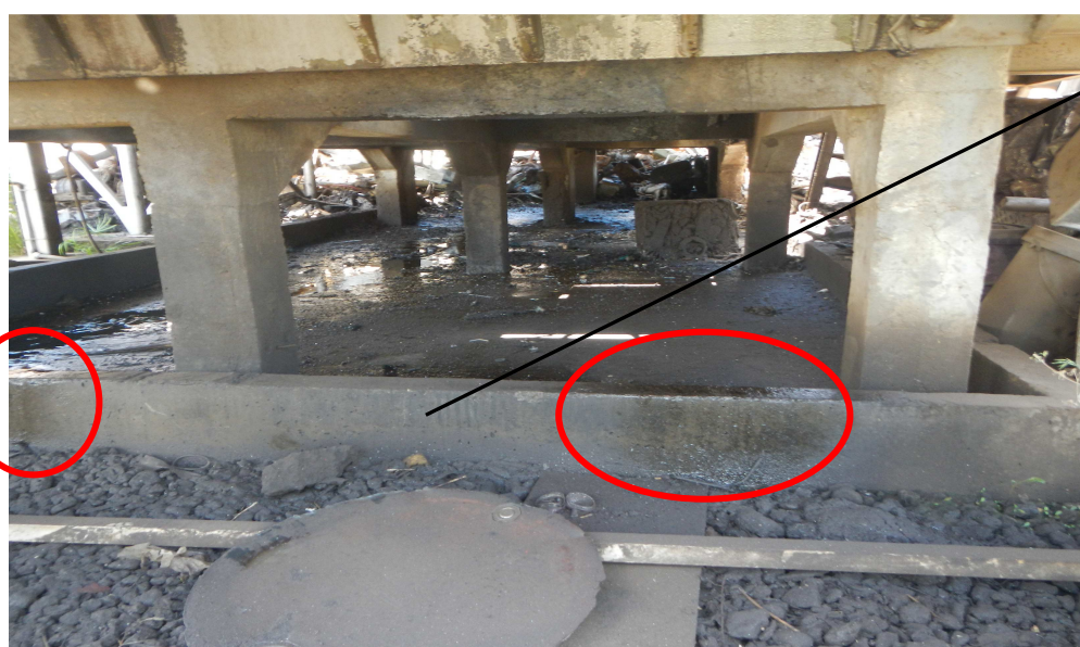
Photo 4 : égouttures constatées hors de la rétention de la presse
