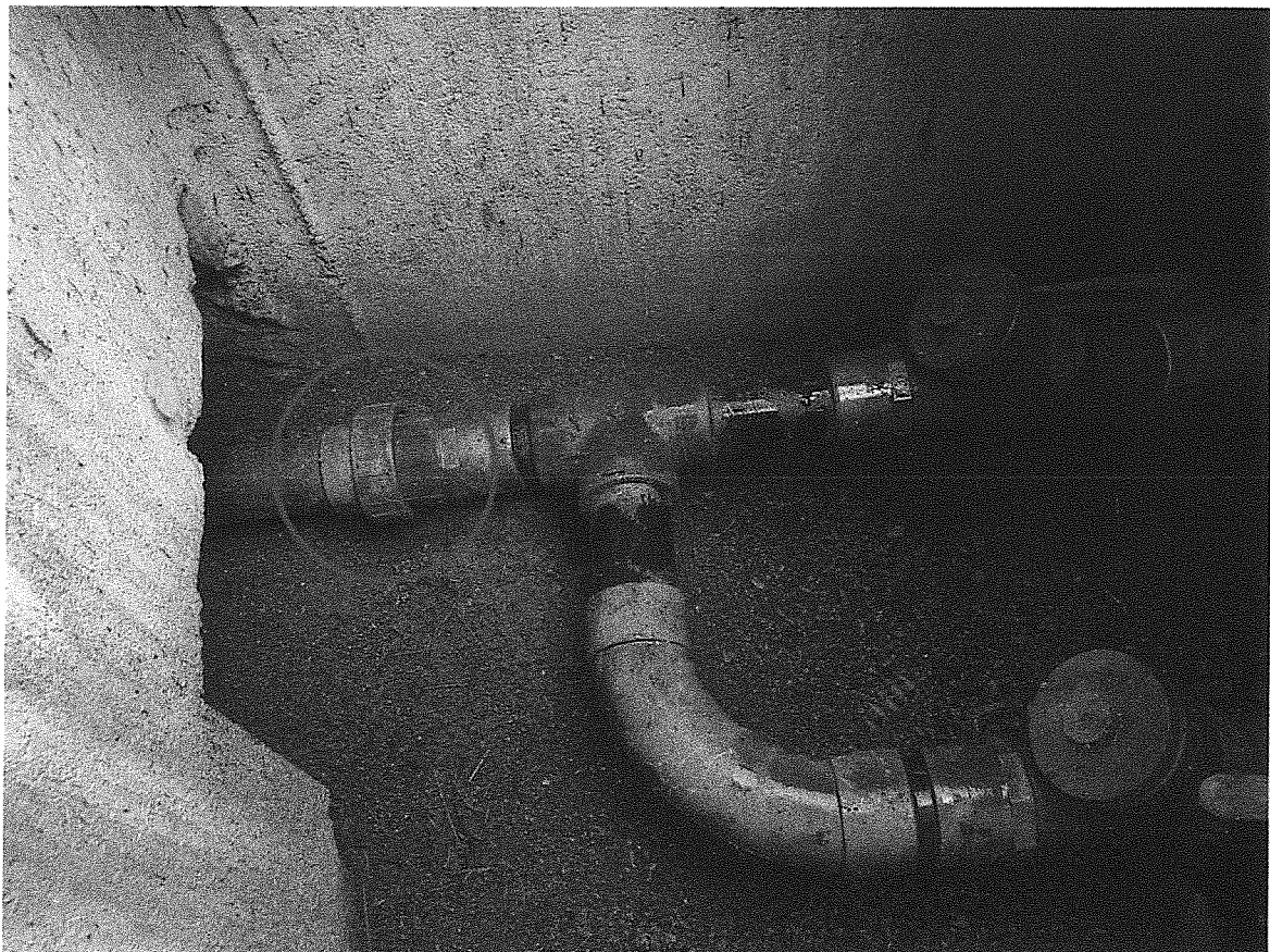
Photo 6 : fuite au niveau de la chambre des vannes du poste de relevage
