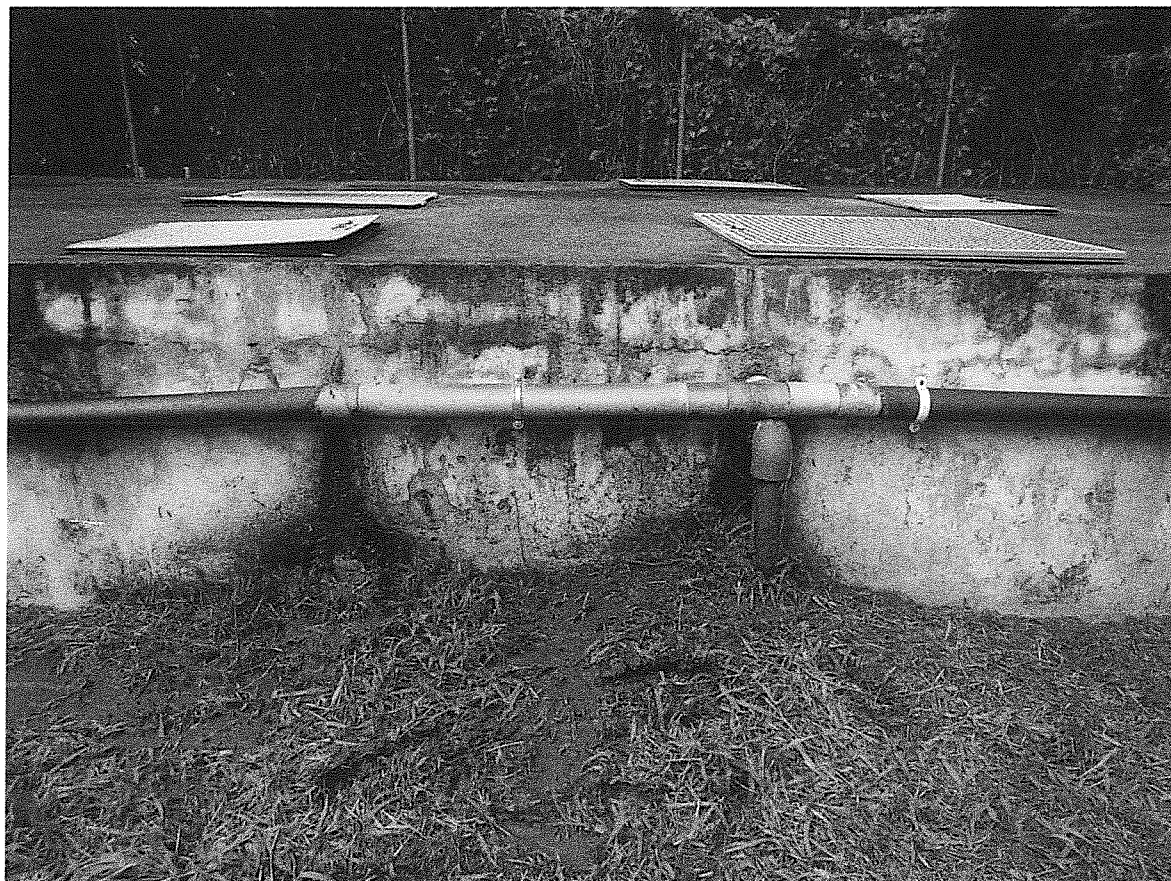
Photo 4 : fuites de boues au niveau de la conduite de recirculation
