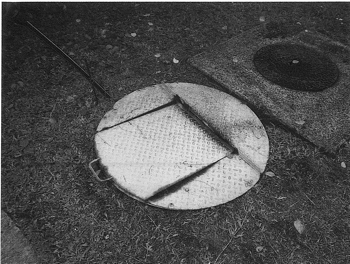
Photo 3 : charnières du tampon du poste de relevage cassées
