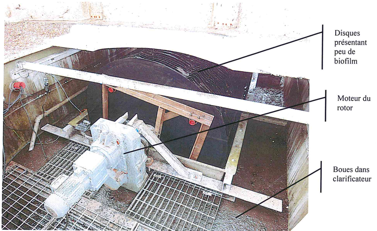
Photo 4 : 2 ème module de disques et clarificateur
