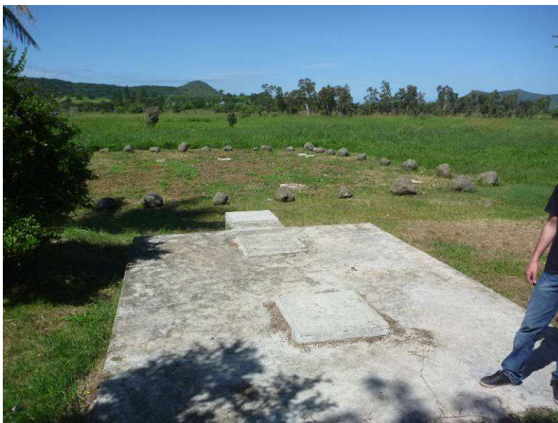
Fosse toutes eaux et tranchées d'infiltration de la cantine
