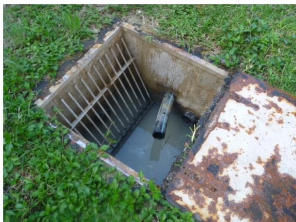
*Dégrilleur en entrée, avec tuyau de refoulement de la cantine*
