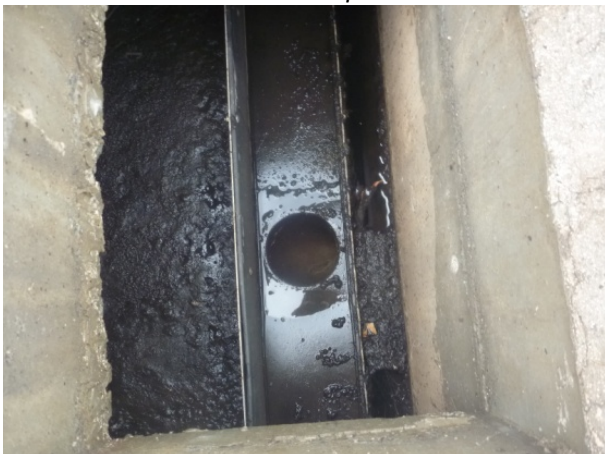
Goulotte de surverse en sortie
