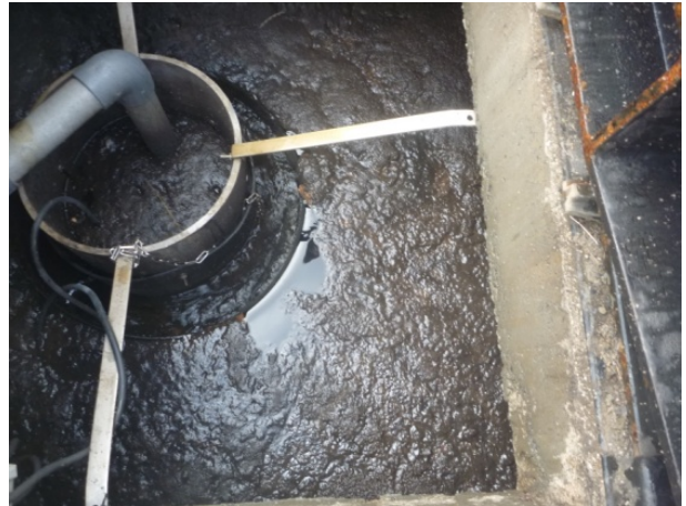
Entrée dans le clarificateur
