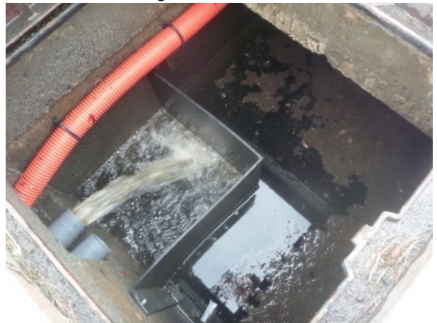
Entrée dans le bassin d'aération
