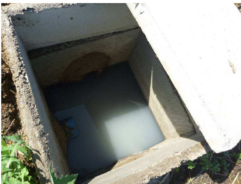
Regard de bouclage de la tranchée d'infiltration de la cantine
