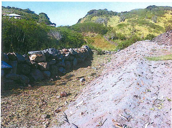
Photo 7 : enrochement au niveau de la plateforme de maturation
