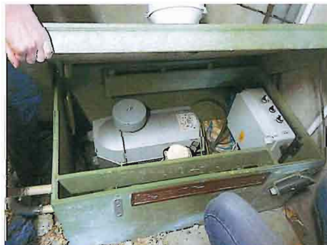
Figure 3: Compartiment insonorisé du compresseur
