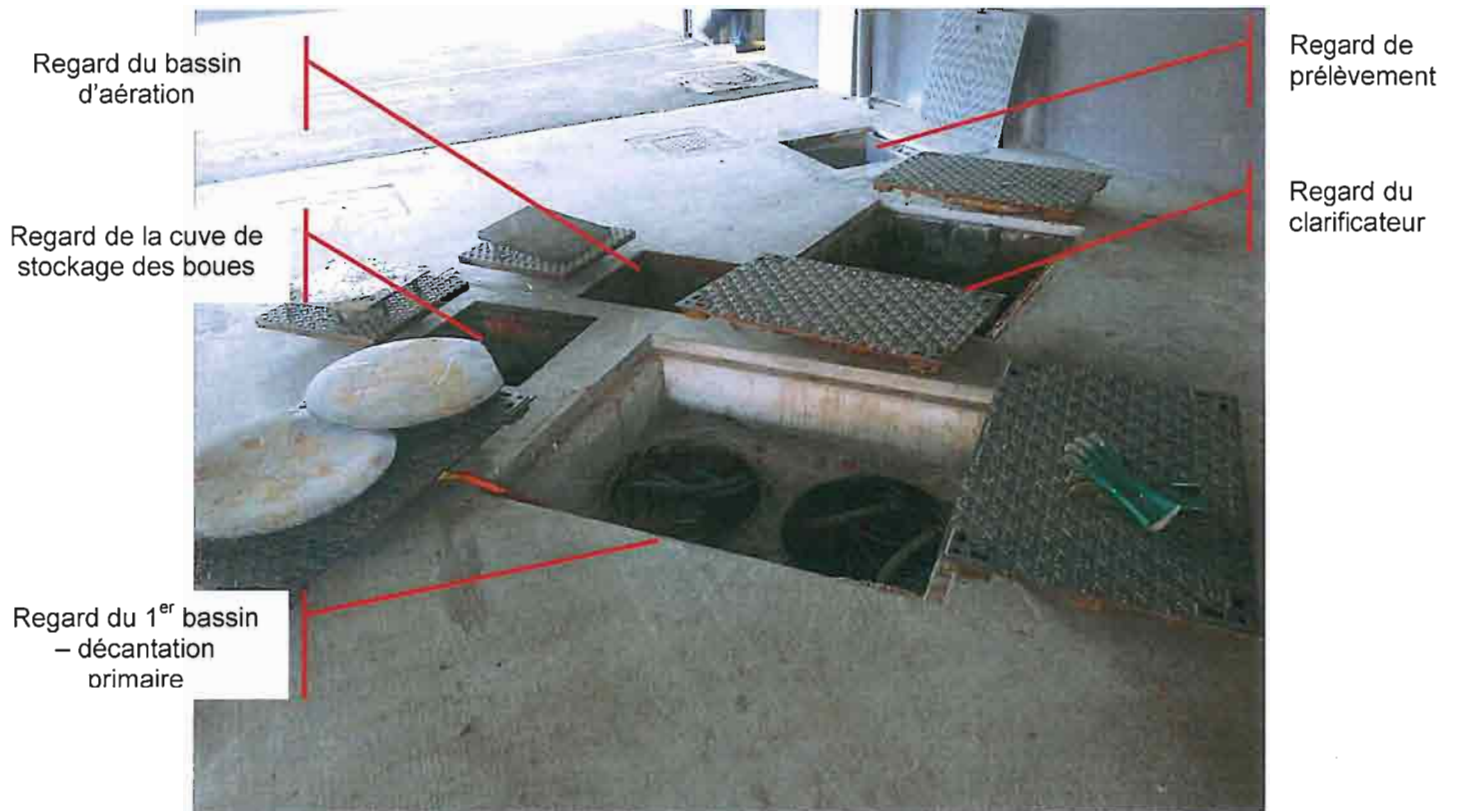
Figure 1: Localisation des regards de la micro-station
