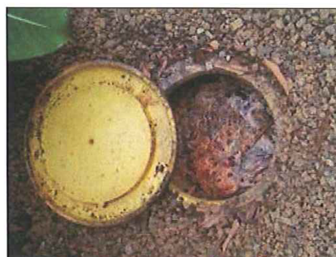
Bac à graisse en sortie de la cuisine
