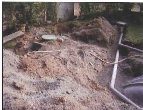
Circuit hydraulique entre la fosse toutes eaux et la miniflo
