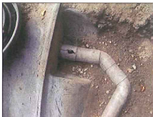
Cassure sur le tuyau PVC en sortie de fosse toutes eaux
