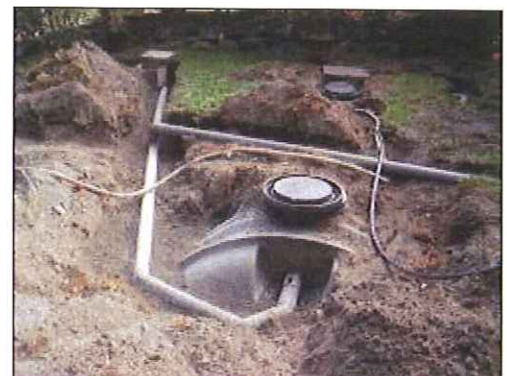
Circuit hydraulique entre la fosse toutes eaux et la miniflo
