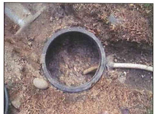
Tuyau de retour en tête des boues de la miniflo à l'entrée de la fosse toutes eaux
