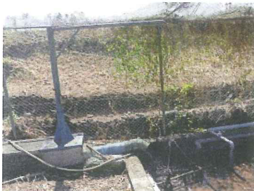
Arrivée des eaux usées, panier de dégrillage hors service
