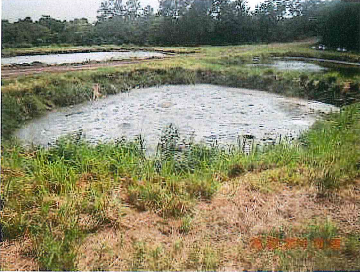
Vue d'ensemble des bassins de lagunage
