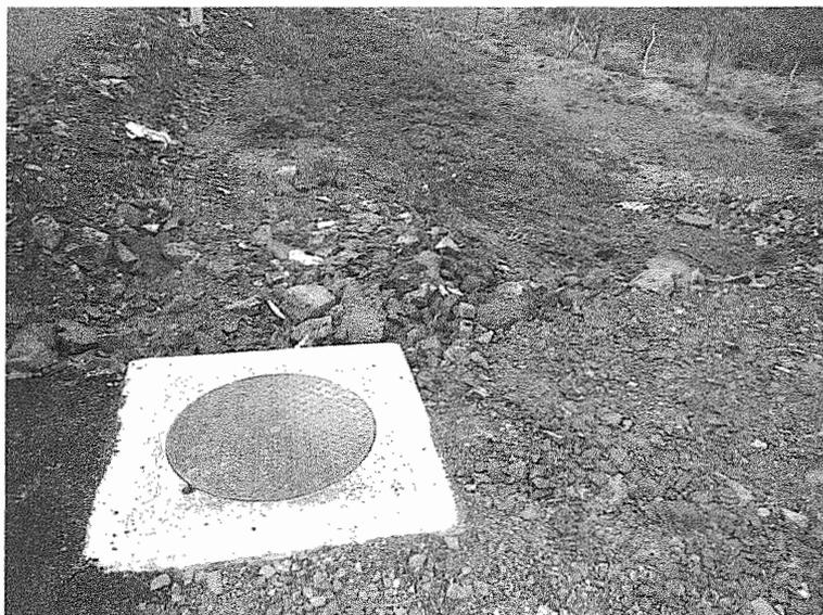
**Figure 2: Regard de collecte des effluents en amont de la cuve**
