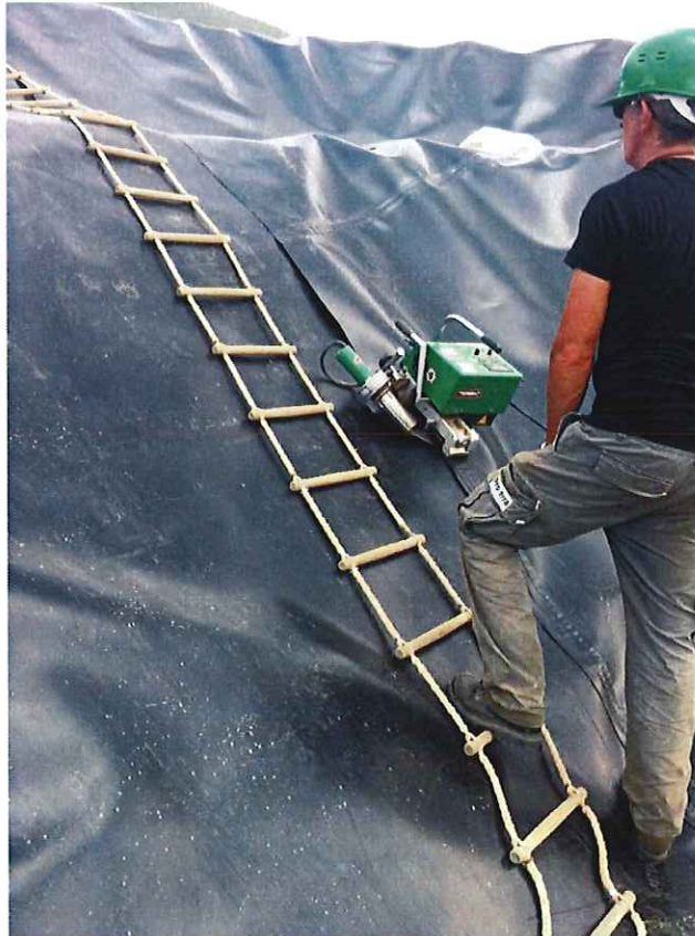
Double soudure à canal central
