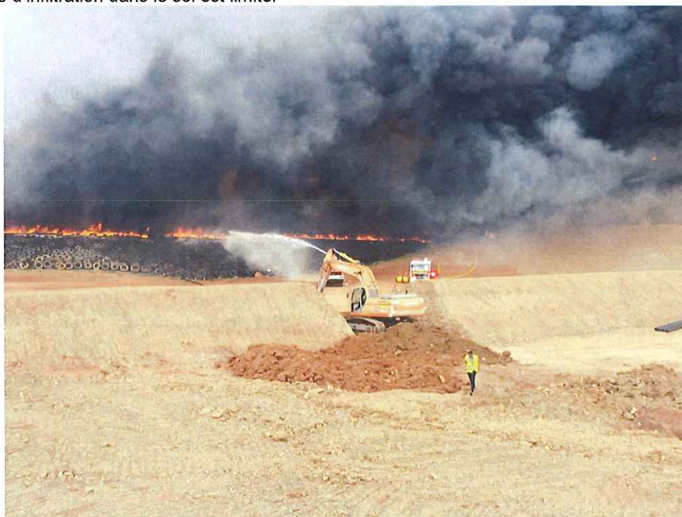
Cliché 1 : mise en place du bouchon argileux
