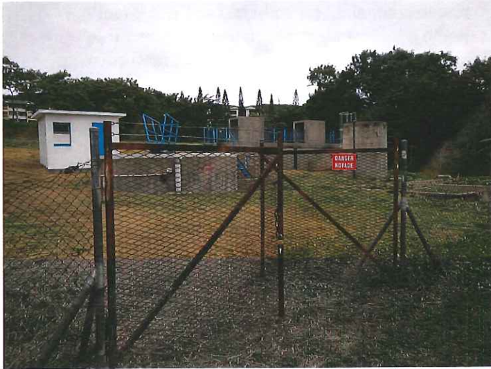
Vue d'ensemble de la station d'épuration
