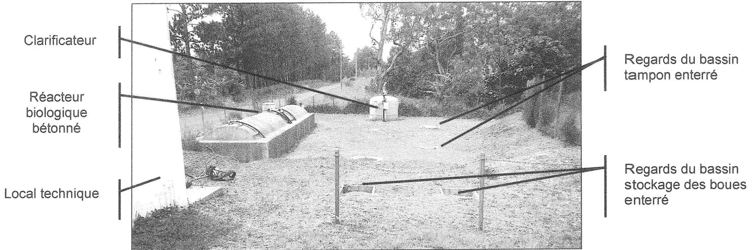
**Figure 1: Localisation des regards et du local technique de la micro-station**
