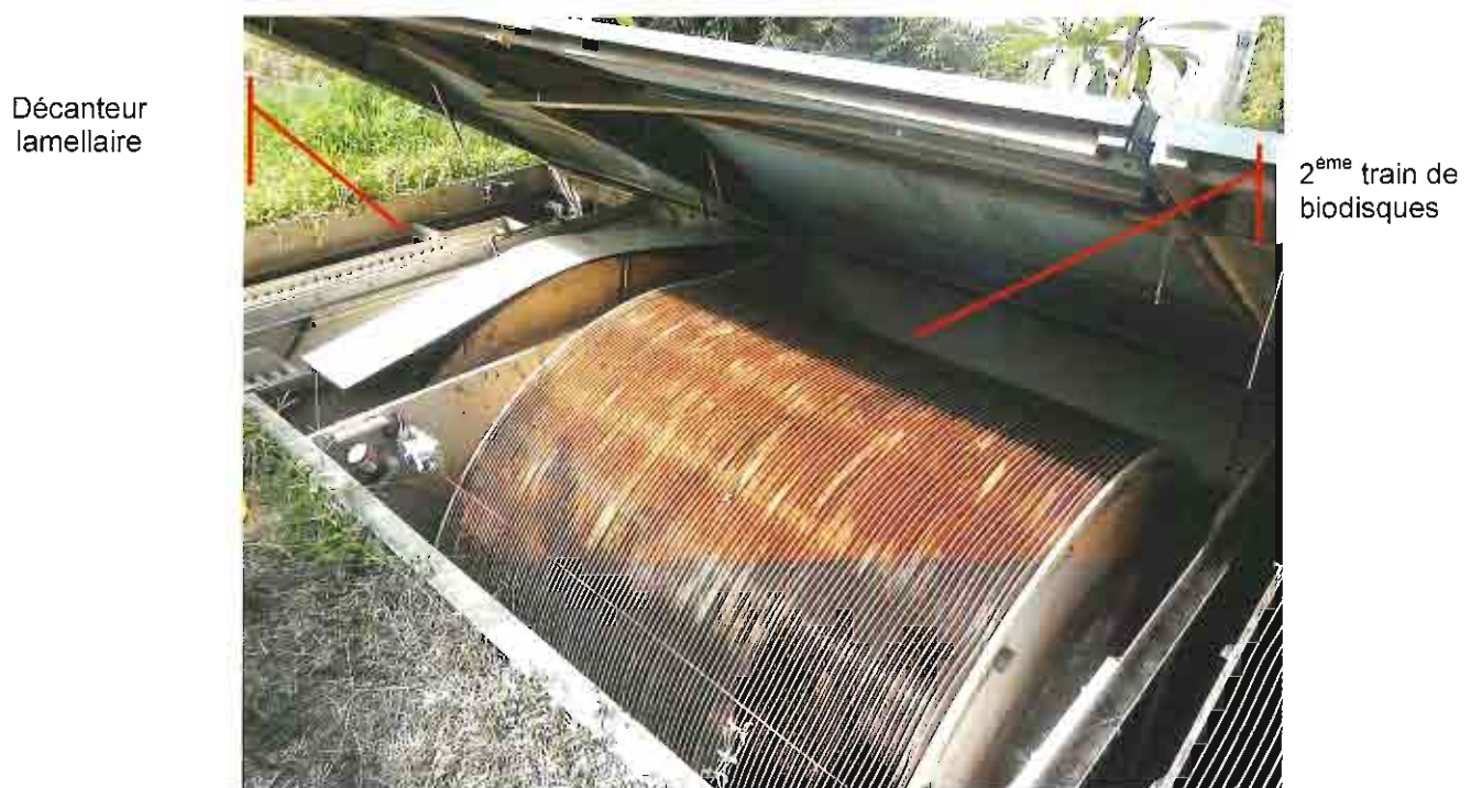
Figure 3: Biodisques et décanteur lamellaire
